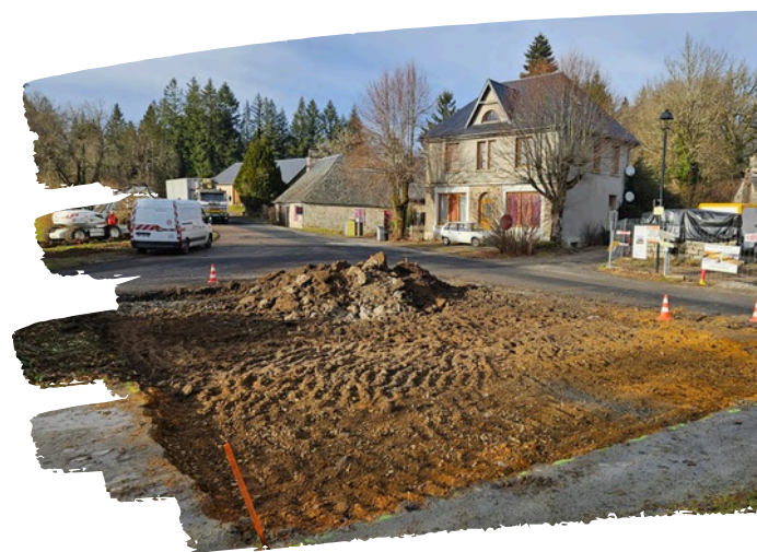
Terrassement de la future Halle sur l'emplacement du monument aux morts
