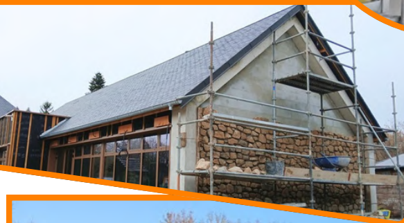
Avant la trêve des confiseurs, l'habillage en pierre est achevé
