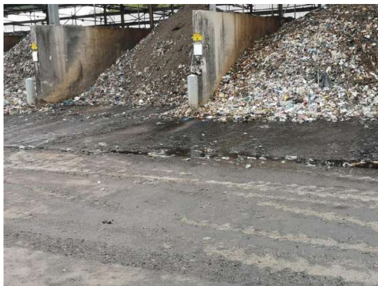
Les box à maturation des matières organiques, devant lesquels une rigole redirige les jus vers la station d'épuration.
