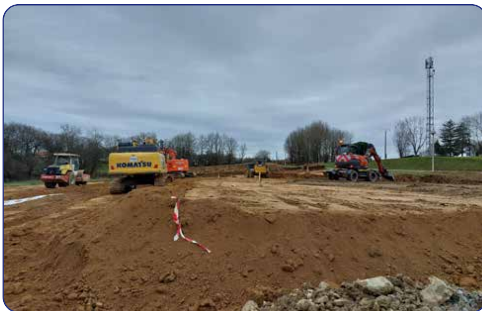
Les travaux ont débuté à Chabanas
