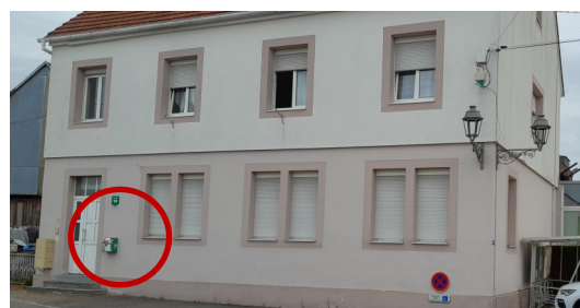
Rue de l'Ecole sur la façade de l'école maternelle, à côté de l'accès aux logements
