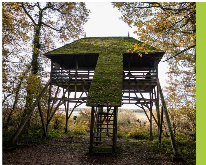
▲ L'observatoire du lac d'Orient avant les travaux de rénovation - ©PnrFO
