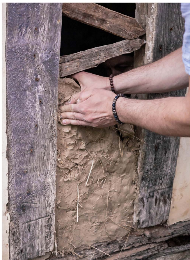
▲ Pose du torchis sur un pan de la façade de la longère de la Maison du Parc - Photo ©PnrFO
