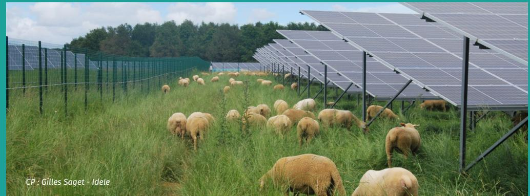
«Une installation agrivoltaïque est une installation de production d'électricité utilisant l'énergie radiative du soleil et dont les modules sont situés sur une parcelle agricole où ils contribuent durablement à l'installation, au maintien ou au développement d'une production agricole».
