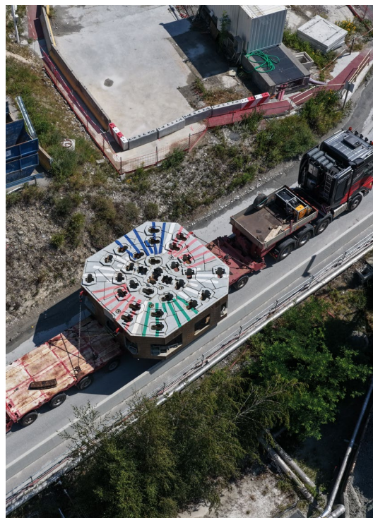
Arrivée du carré central de la roue de coupe, CO5
