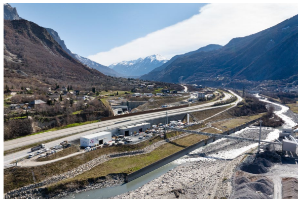
Le chantier du CO8 à Saint-Julien-Montdenis et la vallée de la Maurienne
