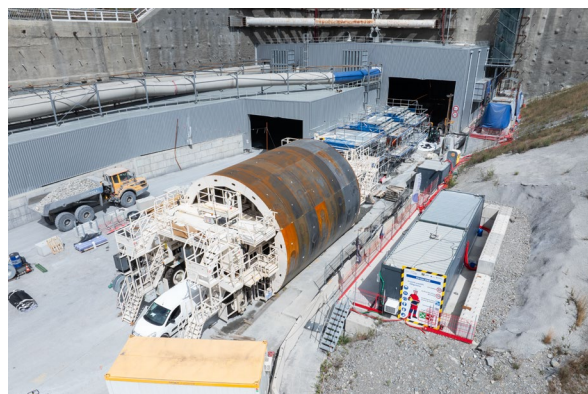
Les nouveaux outils de coffrage, avant leur mise en service dans le second tube
