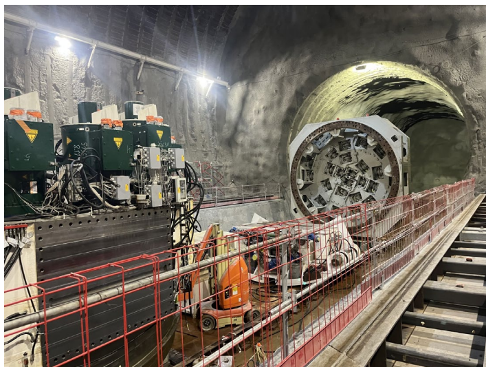
Début du montage de l'un des tunneliers du CO5 en caverne
