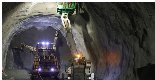
L'excavation traditionnelle dans les galeries
