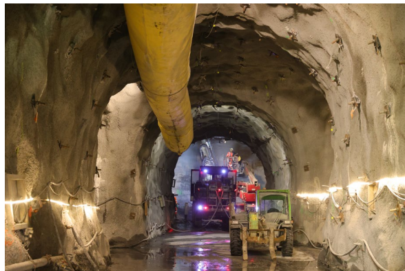
Le creusement des rameaux reliant les deux tubes du tunnel
