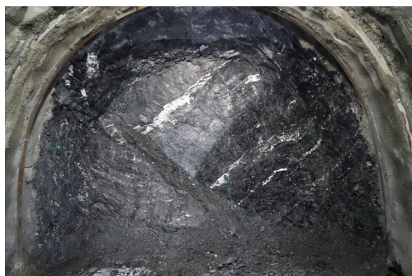
Le front de taille en juillet 2026, dans les schistes ardoisiers
