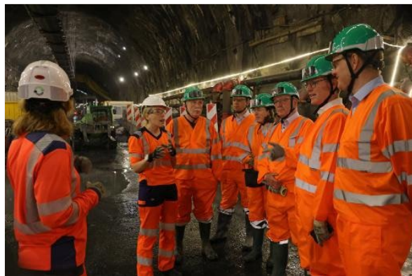
La délégation européenne en visite sur le chantier
