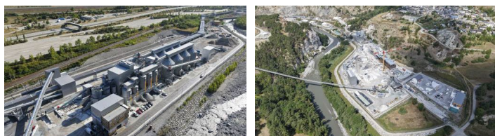
Les stations d'Illaz (à gauche) et du Moulin, en montage
