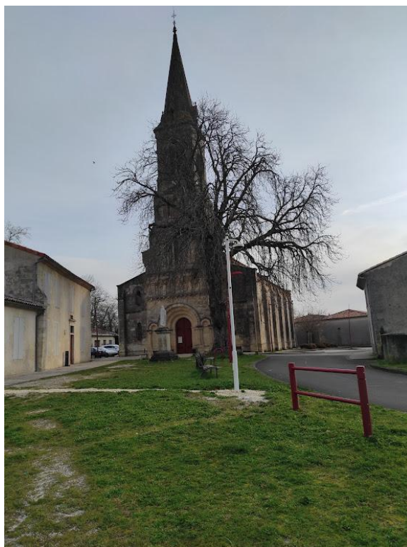
Vue de la façade de l'église Notre-Dame
