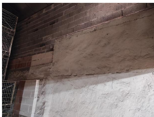
Vue de l'intérieur du bâtiment. On remarque la surélévation en parpaings
