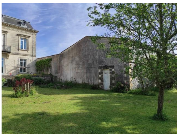
Vue du bâtiment destiné à accueillir une salle de réception
