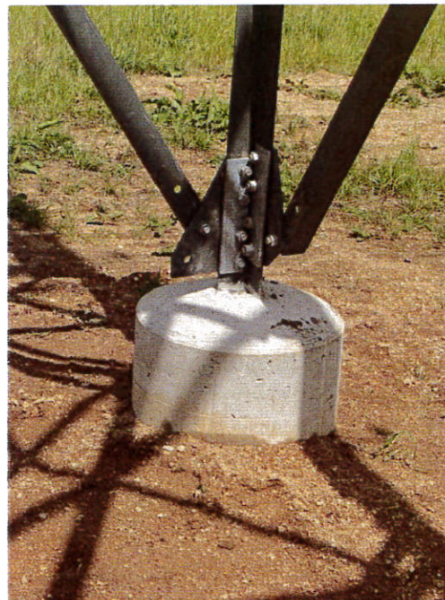
Fondation d'un pylône
