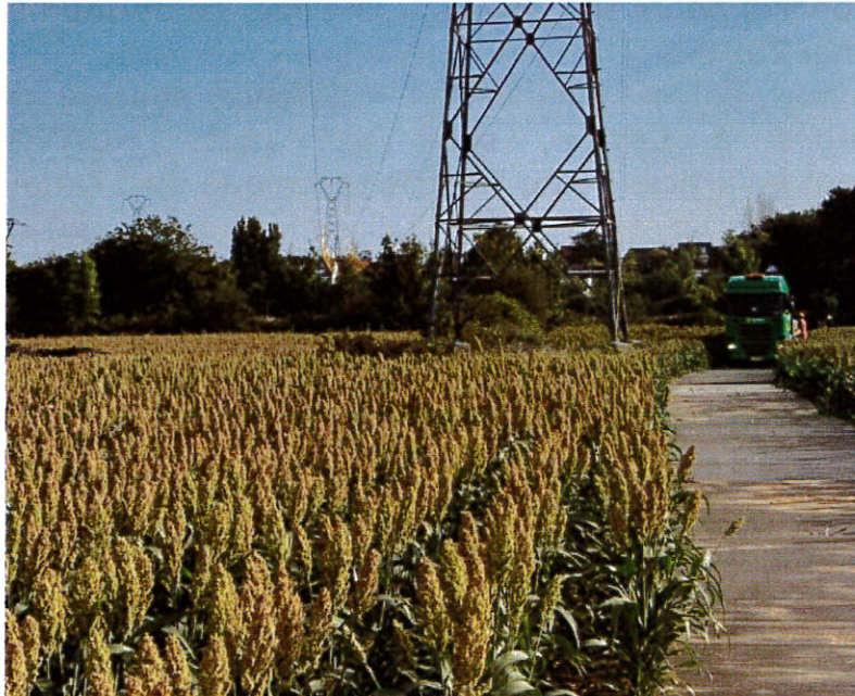
Piste d'accès : plaques de roulage et de répartition de charge
