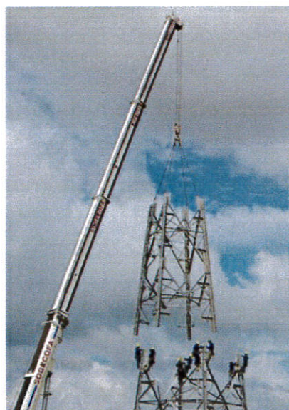
Levage d'un pylône
