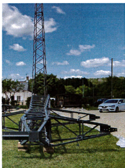
Assemblage d'un pylône
