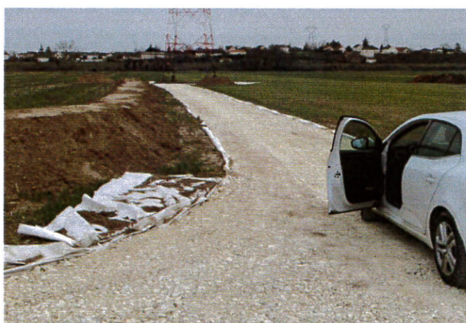
Piste d'accès : géotextile + calcaire
