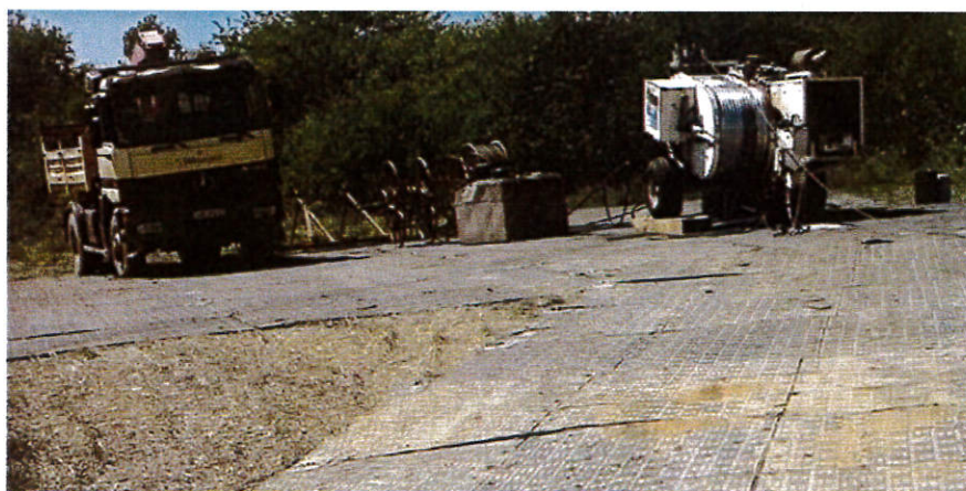
Déroulage sous tension mécanique
