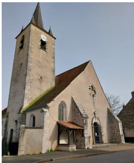
Une étude est en cours pour identifier les étapes nécessaires à la restauration de l'église.
